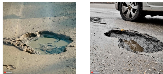
그림 9. 파이어플라이에서 생성된 포트홀 이미지 Fig. 9. Pothole image created by Firefly
