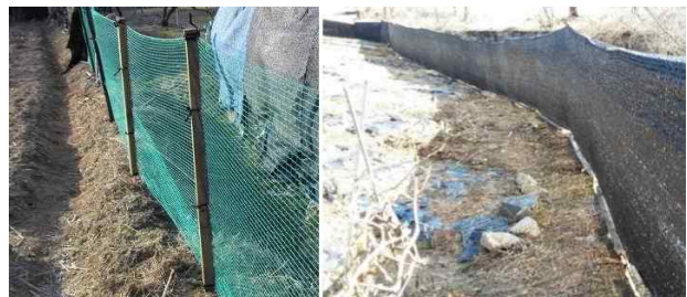
그림 1. 일반적인 야생동물 차단 울타리 Fig. 1. Common Wild Animal Barrier Fence
