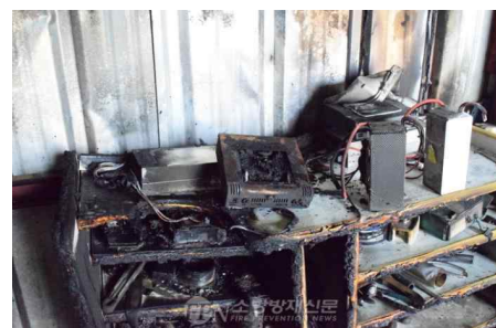
그림 9. 전북 부안 드론용 배터리 충전 중 화재 Fig. 9. Battery charging fire for drones in Buan, Jeollabuk-do
