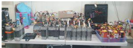
그림 15. 안성 A드론교육원 리튬배터리보관실 Fig. 15. Anseong A-Drone Education Center Lithium Battery Storage Room
