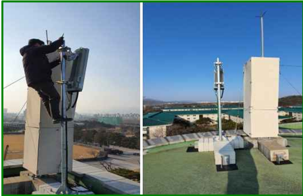
그림 6. 작전지역 5G 네트워크 기지국 설치 Fig. 6. Installation of 5G Base Stations in Field of Operations
